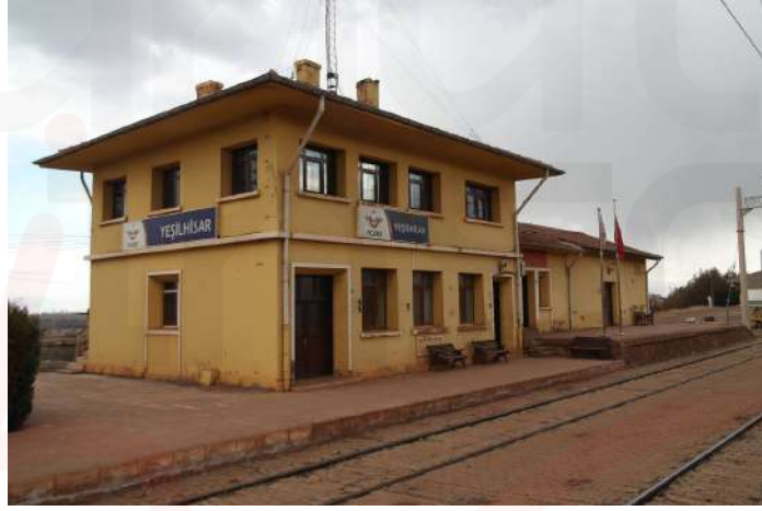
Fotoğraf 1. İstasyon Binasının Genel Görünümü
