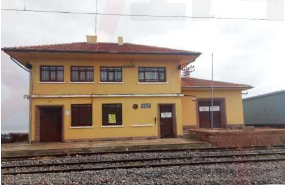
Kayseri/Başköy İstasyon Binası
