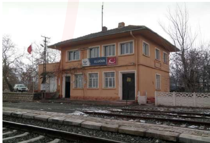
Elazığ/Uluova İstasyon Binası
