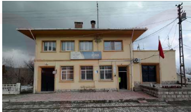
Elazığ/Kürk İstasyon Binası
