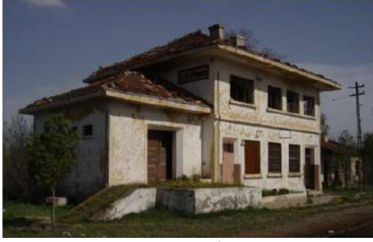
Kayseri/Beydeğirmen İstasyon Binası
