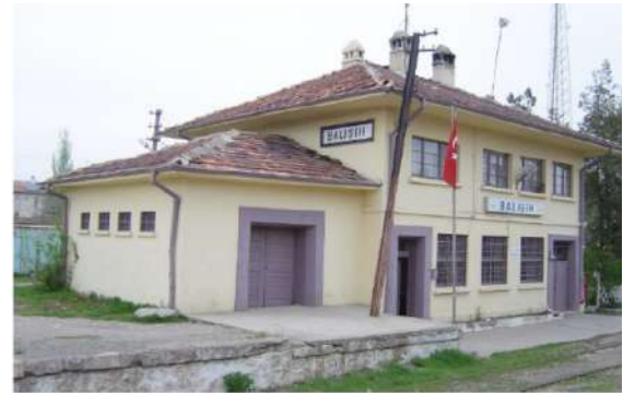
Kırıkkale/Balıh İstasyon Binası
