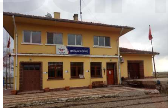
Kayseri/Boğazköprü İstasyon binası
