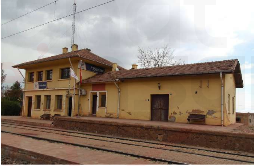
Fotoğraf 13. Tek Katlı Binanın Batı Cephe Görünümü
