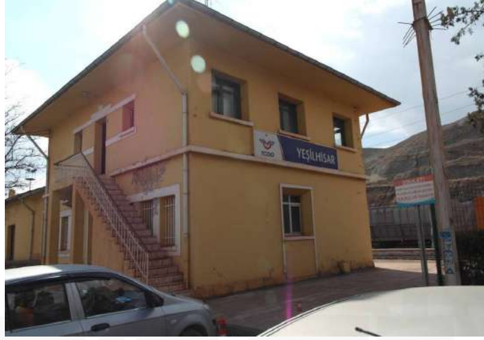
Fotoğraf 17. Kuzey Cephe Görünümü
