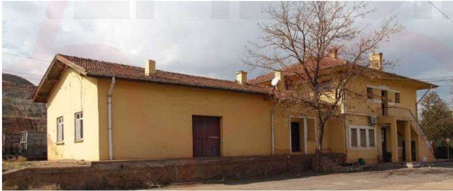
Fotoğraf 15. Güney Cephe Görünümü
