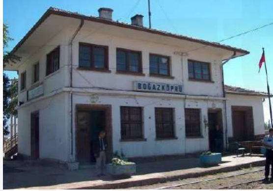
Kayseri/Boğazköprü İstasyon Binası
