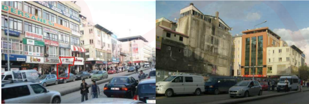
Görsel 26. Van Depremi ile yıkılan Soydan İş Merkezi (a) Deprem Öncesi (b) Deprem Sonrası
