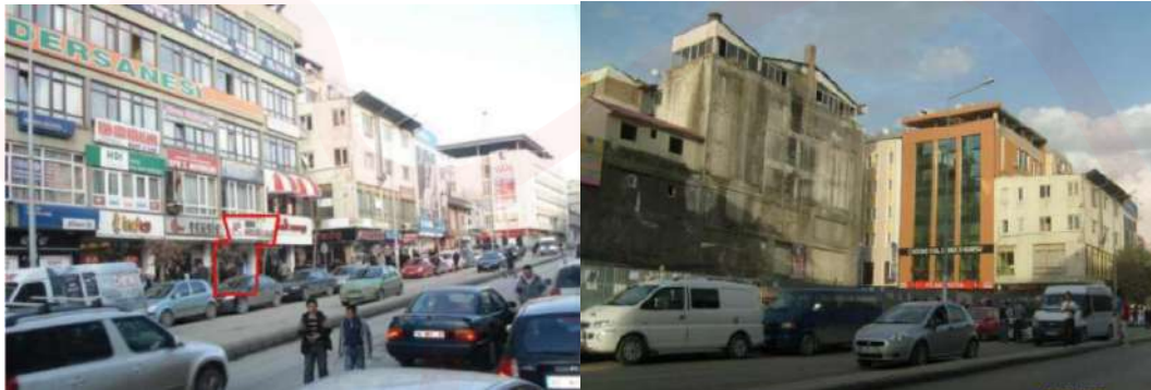
Görsel 26. Van Depremi ile yıkılan Soydan İş Merkezi (a) Deprem Öncesi (b) Deprem Sonrası
