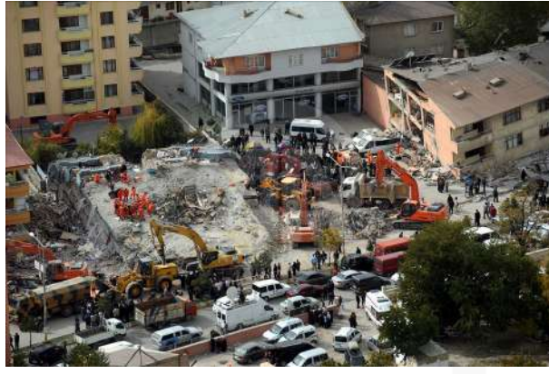
Görsel 24. Van Depremi ile Maraş Caddesinde Yıkılan Sefa Apartmanı
