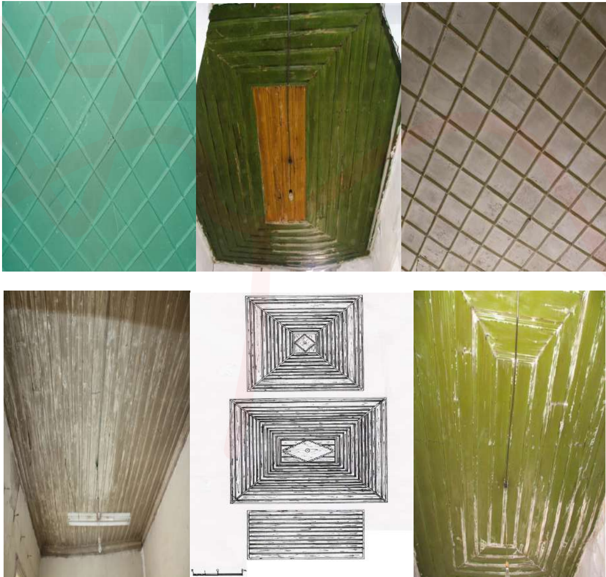
Görsel 26-30; Çizim 22. Geleneksel Van Evleri Ahşap Tavan Kaplama Plan ve Görünüşleri (Kaynak: Ş. Öztürk-1996)
