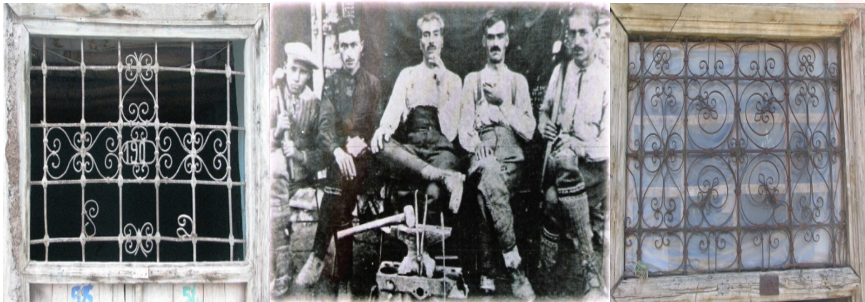
Görsel 3-5. Giriş Kapısı Üzeri Metal Ferfoje ve Demir İşlemciliği Usta-İşçi Görünüşleri (Kaynak: Ş. Öztürk-1996)
