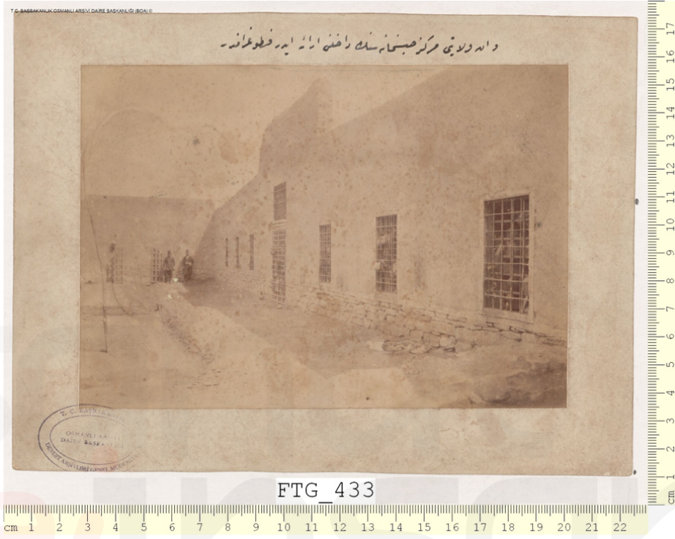
Görsel 11: Van Merkez Hapishanesi (Timur Paşa Konağı) iç mekânı
