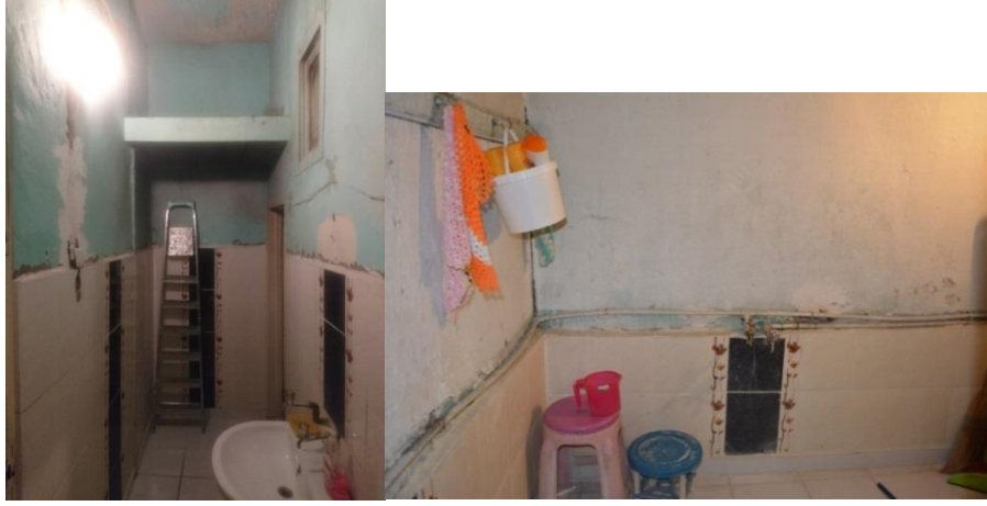
Foto.23: Banyo- lavabo bölümünden görünüm
