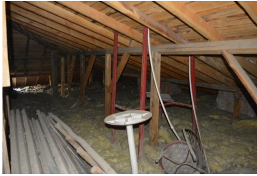
Foto.28: Çatı katından görünümler
