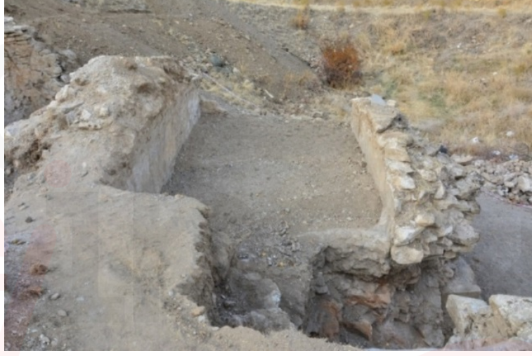
Foto 11. Kuzeydoğu Cephesi, Külhan Bölümü
