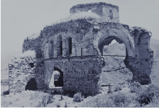
Foto 14. Kuzey cepheden görünüm (1985)
