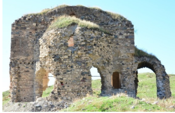
Foto 13. Doğu cepheden görünüm
