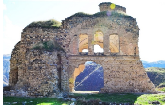
Foto 15. Kuzey cepheden görünüm (2018)
