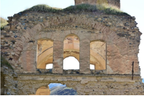
Foto 19. Kuzey cephe pencerelerden detay (F. Şedele,1985)
