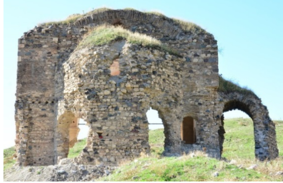
Foto 13. Doğu cepheden görünüm
