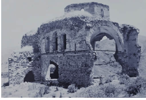
Foto 14. Kuzey cepheden görünüm (1985)
