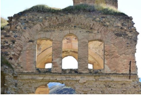
Foto 19. Kuzey cephe pencerelerden detay (F. Şedele, 1985)
