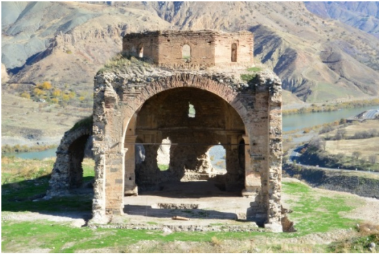
Foto 9. Kazıda çıkan batı cephesi duvar izleri
