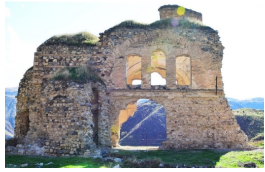
Foto 15. Kuzey cepheden görünüm (2018)
