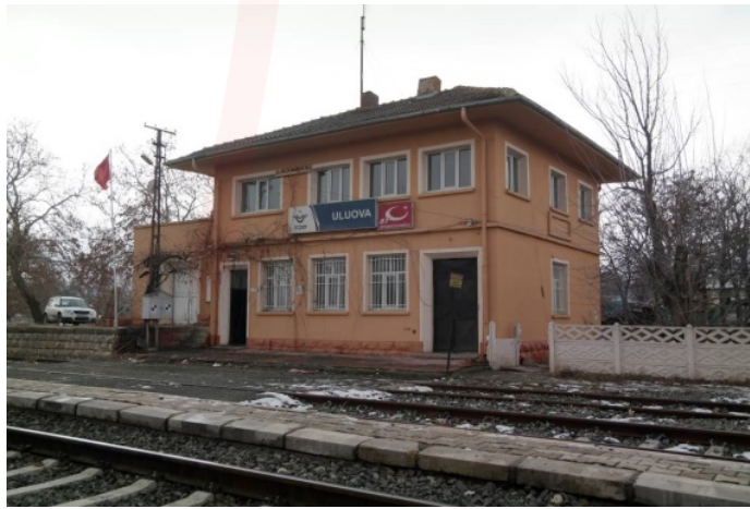
Elazığ/Uluova İstasyon Binası
