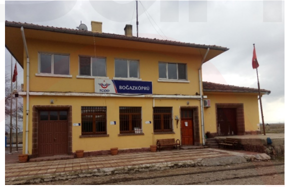
Kayseri/Boğazköprü İstasyon binası
