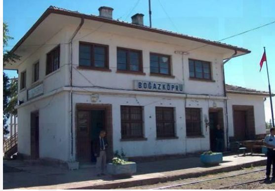
Kayseri/Boğazköprü İstasyon Binası
