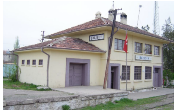
Kırıkkale/BalışehİR İstasyon Binası
