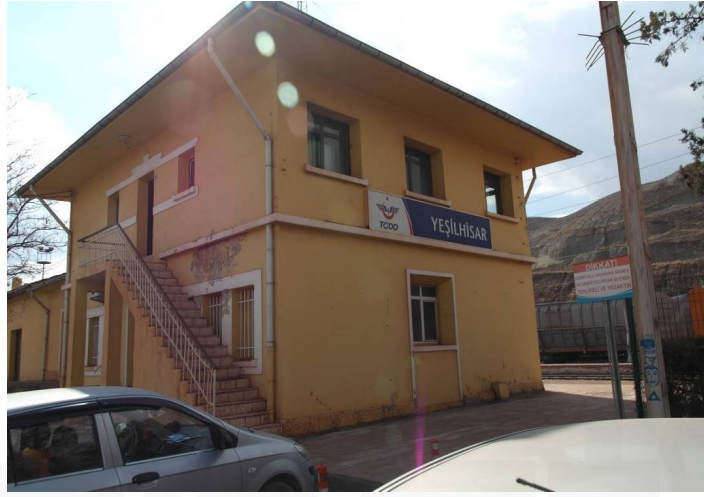
Fotoğraf 17. Kuzey Cephe Görünümü
