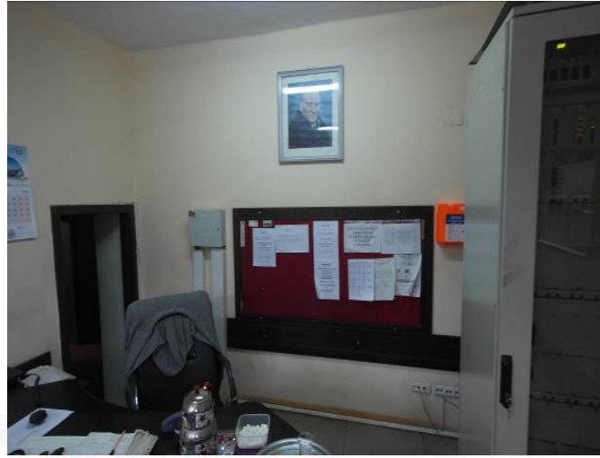
Fotoğraf 9. Kuzeydoğuda Yer Alan Oda
