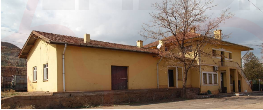
Fotoğraf 15. Güney Cephe Görünümü
