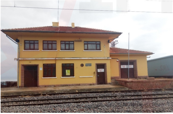
Kayseri/Başköy İstasyon Binası
